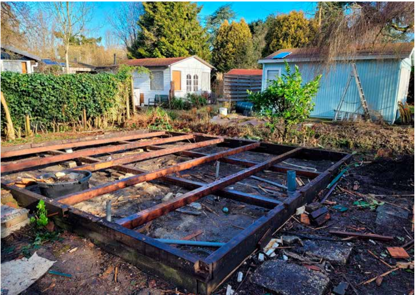
Alleen de grondbalken lagen er nog
