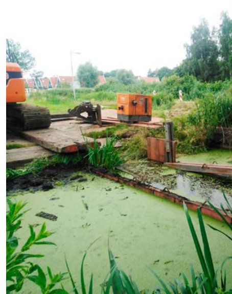
Bij de pomp aan de Wijkergouw werd een nieuwe damwand geslagen.
